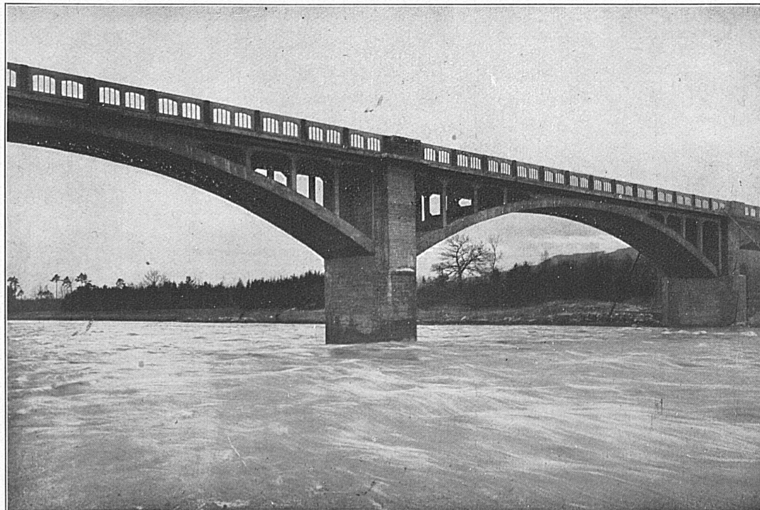
Strassenbrücke über die Thur bei Weinfelden
