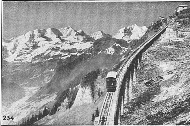
SEILBAHN NIESEN, Berner Oberland. Totale Länge 3496 m, überwundene Höhe 1645 m. Maximalsteigung 68%
