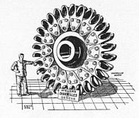
→ ROUE D'UNE DES TURBINES DE 20 000 cv.
