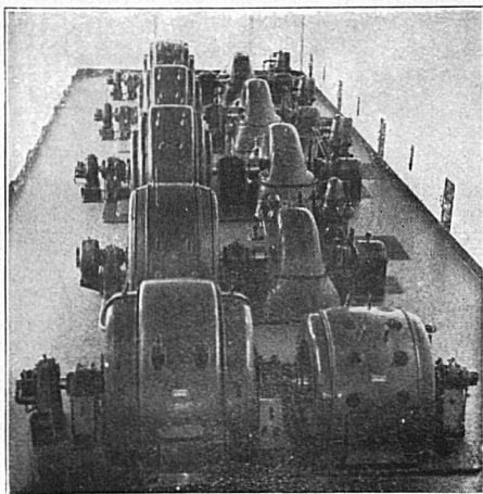
Maschinensaal d. Kraftwerkes Küblis d. A.-G. Bündner Kraftwerke, Leistung 47,000 PS
