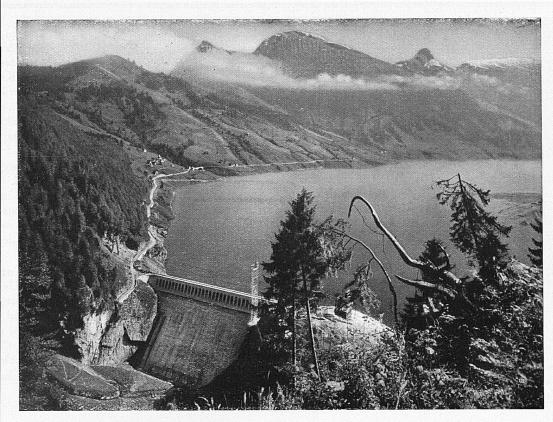
Staumauer im "Schräh", Wäggital Gemeinsam ausgeführt mit Ed. Züblin & Cie. A.-G-Die Mauer hat eine grösste Höhe von 112 m, wovon 46 m unter dem Talboden und 66 m über der Talsohle liegen. Die Kronenlänge der Mauer beträgt 186 m
