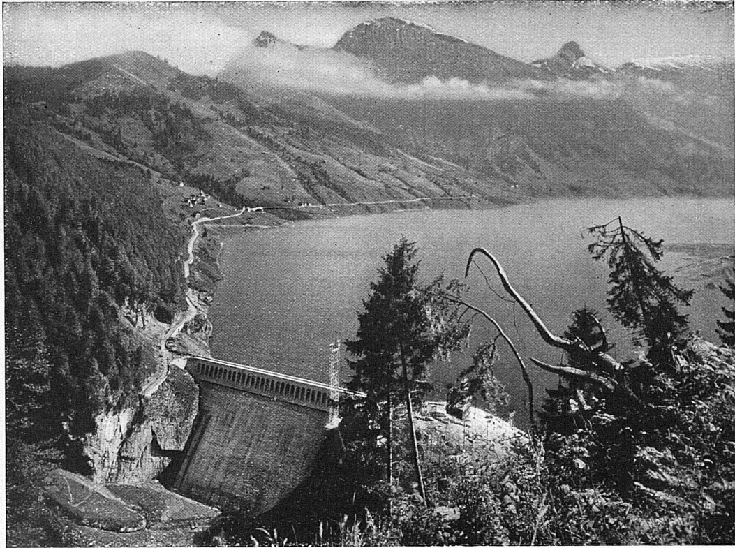
Staumauer im „Schräh“, Wäggital Gemeinsam ausgeführt mit Ed. Züblin & Cie. A.-G.
