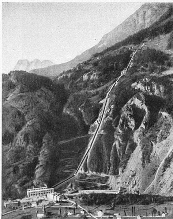
Ansicht der Hochdruck-Wasserleitung Vernayaz
