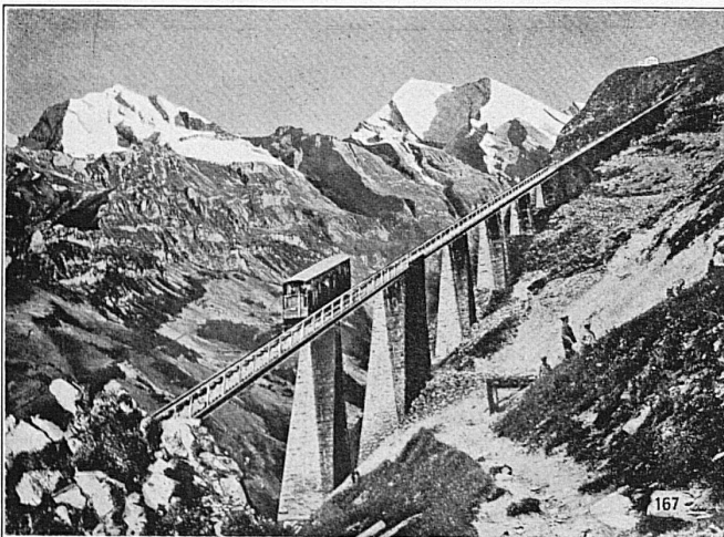
SEILBAHN NIESEN, Berner Oberland. Totale Länge 3496 m, überwundene Höhe 1643 m, Maximalsteigung 68%
