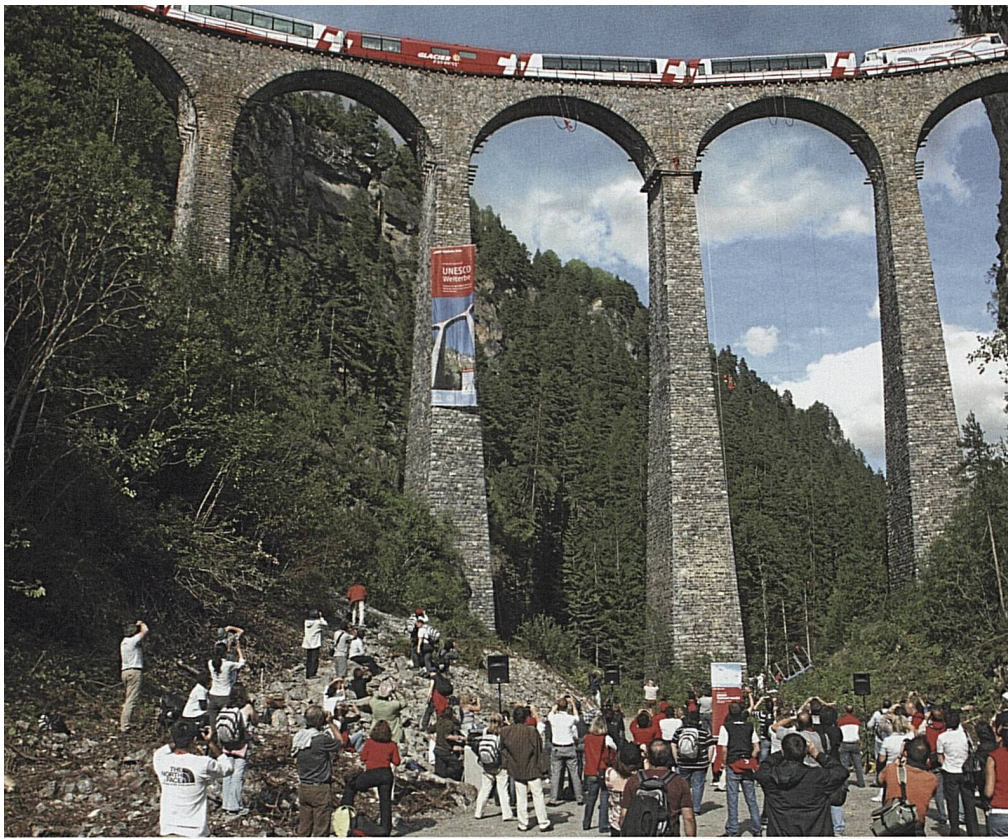
Sinnbild für ein nachhaltiges Naturerlebnis Schweiz: Das Landwasserviadukt bei Filisur GR stand im Fokus... Symbole des merveilles des paysages suisses: le viaduc de Filisur (GR), objet de fascination...
