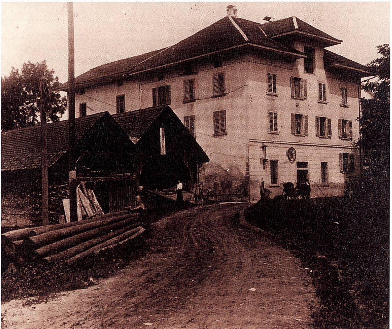
Die Vorstadtmühle im Jahre 1912 mit Hauptgebäude und Nebenbauten.
