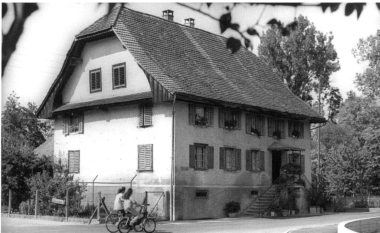
Der vor dem Abbruch 1994 durchgeführte Bauuntersuch wies im ursprünglichen Haus eine Bohlständerkonstruktion aus den Jahren 1575–1580 nach. Beim so genannten «Hellmüllerhaus» könnte es sich um den Hof in der Bützen, neben der steinernen Brücke über die Sure handeln.
