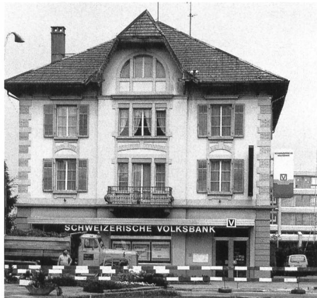
Das erste Gebäude der Schweizerischen Volksbank, welches bis 1972 die Molkerei Theiler beherbergte. Aufnahme vom 9. Mai 1986 kurz vor dem Abbruch.
