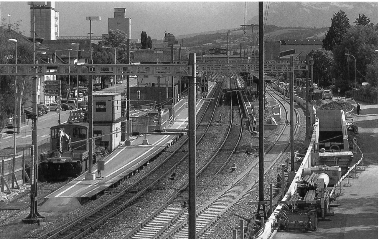
Die Geleiseanlage am Bahnhof Sursee kurz vor (oben) und nach (unten) dem Bau des 3. Geleises.
