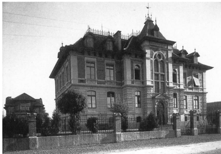
Das 1901 im Neurenaissance-Stil errichtete Schul- und Konviktgebäude der Landwirtschaftlichen Schule.
