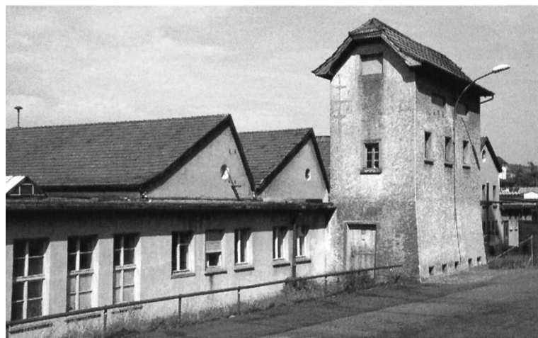
Der Anschluss an das Stromnetz erhöhte die Produktivität. Transformator-Turm beim Fabrikgelände an der Rigistrasse.
