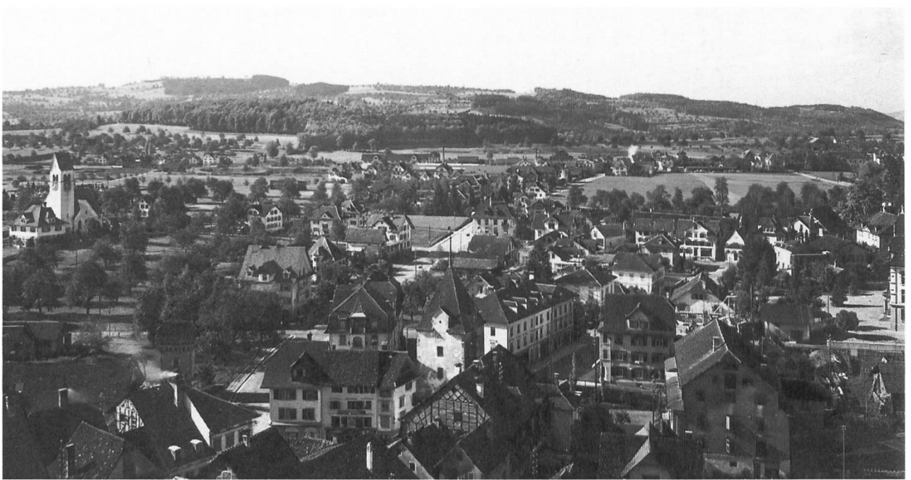
Die Eisenbahnvorstadt mit den ersten Bauten von Fritz Amberg an der verlängerten Centralstrasse. Aufnahme 1924.
