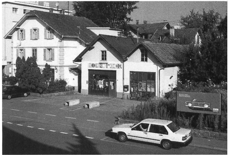
Wohn- und Gewerbebauten auf der so genannten «Käppelimmatt» vor dem Abbruch. Aufnahme 1999.
