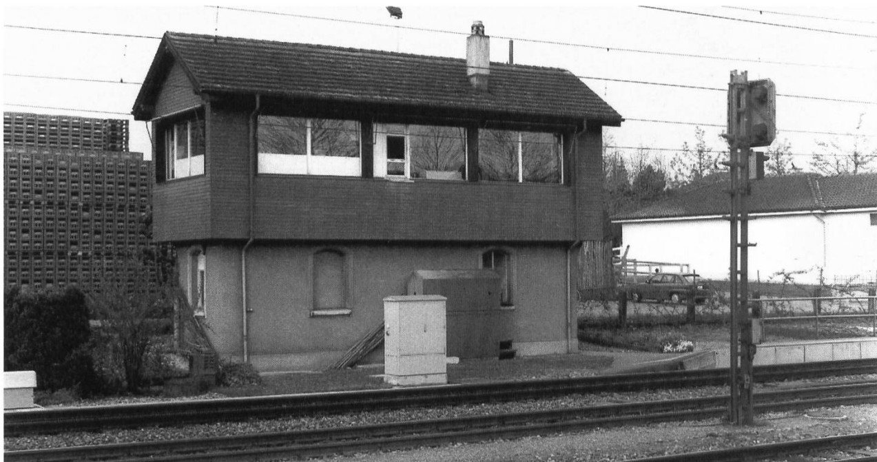
Das 1912 errichtete mechanische Stellwerkgebäude auf der Station Sursee. Aufnahme von 2001 kurz vor dem Abbruch.
