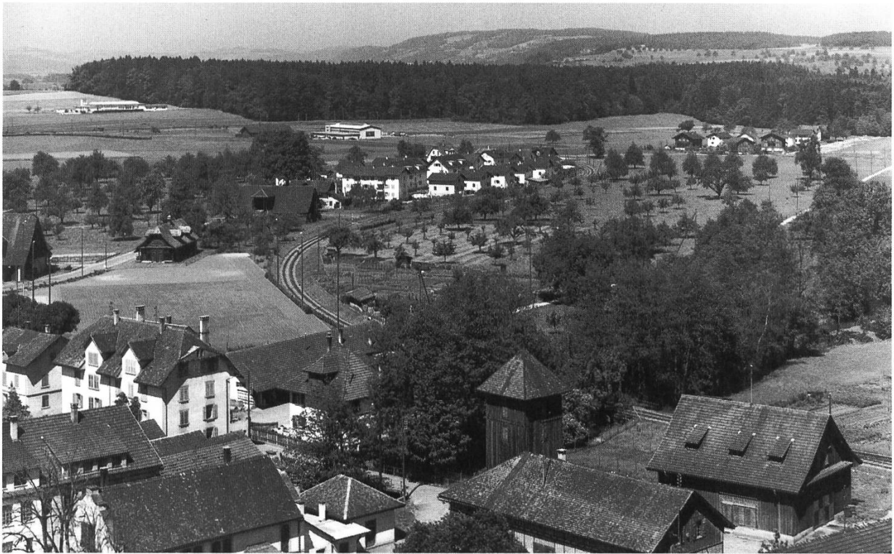
Das Wohnquartier im Kleinfeld. Im Hintergrund die neuen Fabrikationsgebäude von Kleider Frey im Kotten sowie der Maschinenfabrik Koch. Aufnahme um 1955.
