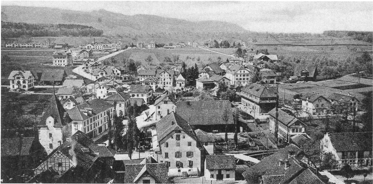
Die Eisenbahnvorstadt mit den Häusern an der Bahnhof – und der alten Centralstrasse um 1900.
