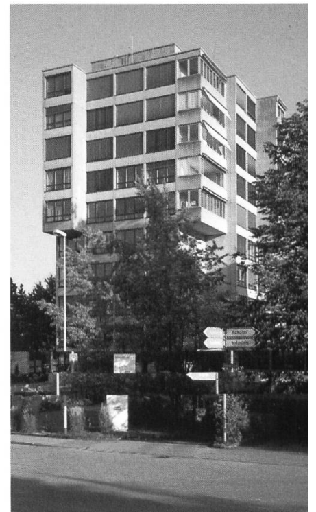
Das Verwaltungsgebäude des VLGZ von Architekt Ulrich Bögli, Luzern, dominierte als einziger «Wolkenkratzer» das Bahnhofquartier. Aufnahme 2006.
