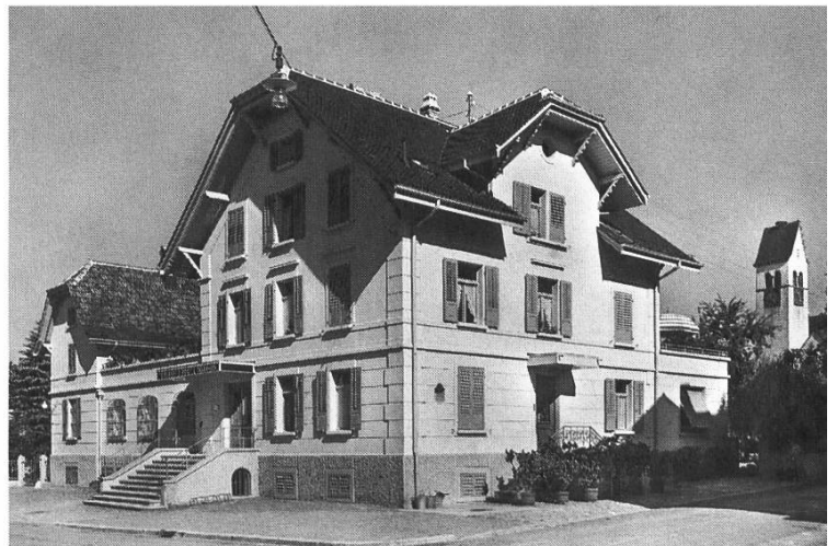
Der Chrüzlihof von 1895, der ab 1920 als Postgebäude genutzt wurde. Aufnahme um 1950.
