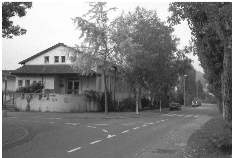
Die 1946 errichtete Zigarrenfabrik Villiger wird heute als Schulhaus genutzt. Aufnahme 2006.
