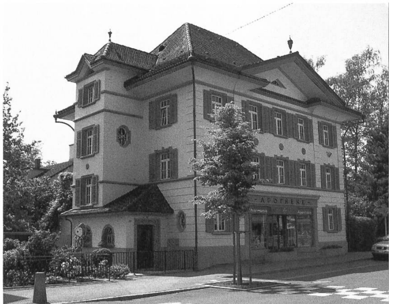
Die 1929 von Architekt Fritz Amberg für Karl Kathriner erbaute Apotheke an der Centralstrasse.
