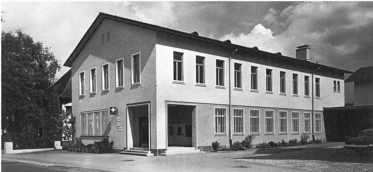
Das neue Postgebäude von Hans Erni und Josef Wey, 1955 unweit des alten Standorts gebaut.
