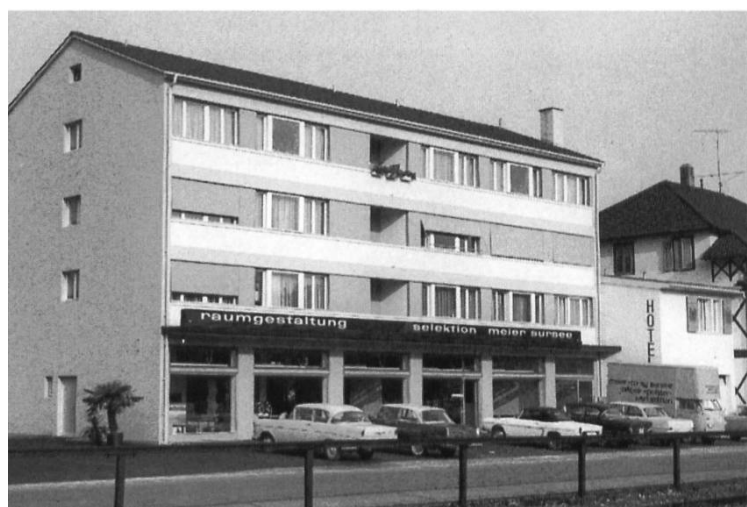
An Stelle des Saales baute Architekt Hans Erni 1962 ein modernes Wohn- und Geschäftshaus.
