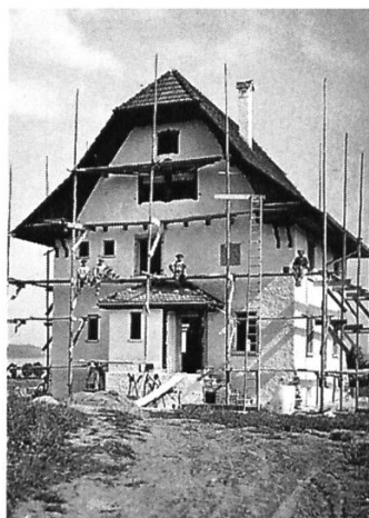
Einem Landschlösschen ähnelt die Villa «Waldburga» von Louis Gut. Aufnahme des Bauherrn während der Bauzeit 1923.
