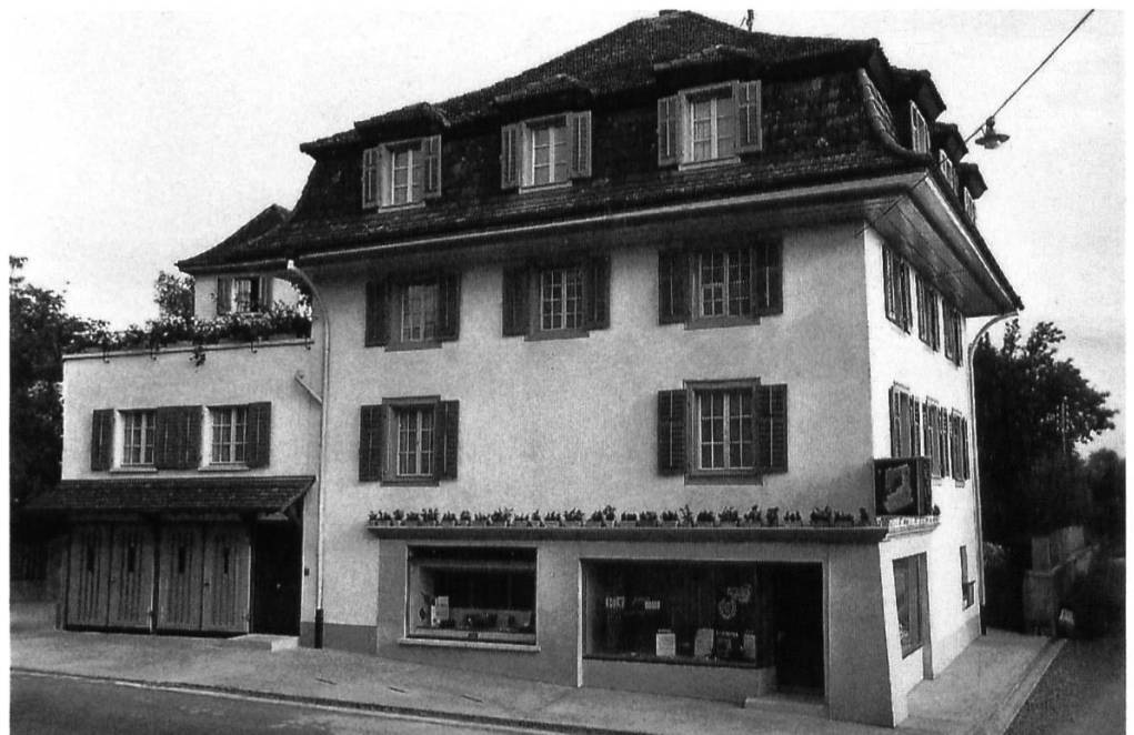
Wohn- und Geschäftshaus Sidler, Badstrasse. Auch dieses Haus geht in der Grundstruktur ins 18. Jahrhundert zurück und wurde mehrmals überformt. Aufnahme 1953.
