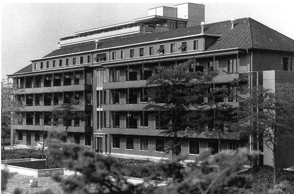
Das ehemalige Bezirksspital wurde nach einem Umbau 1979 zum regionalen Pflegeheim. Aufnahme 1979.
