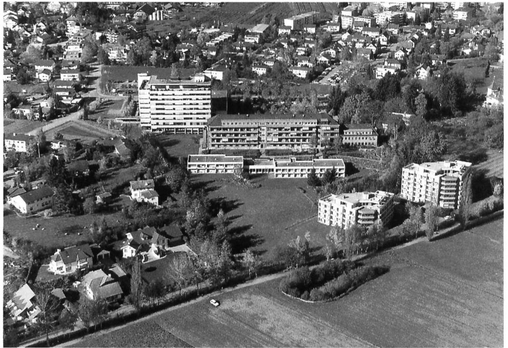
Spitallandschaft mit kantonalem Spital, regionalem Pflegeheim sowie Schwesternhäusern. Luftaufnahme 1994.
