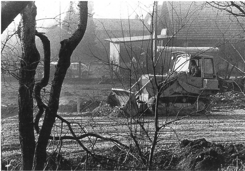
Mit dem Bau der Roman-Burri-Strasse wurde das Quartier von einer weiteren stark befahrenen Strasse durchschnitten. Aufnahme bei Baubeginn 1973.
