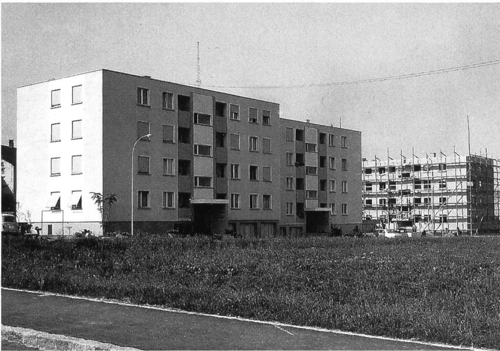
Bauboom an der Sonnhaldestrasse. Aufnahme 1969.
