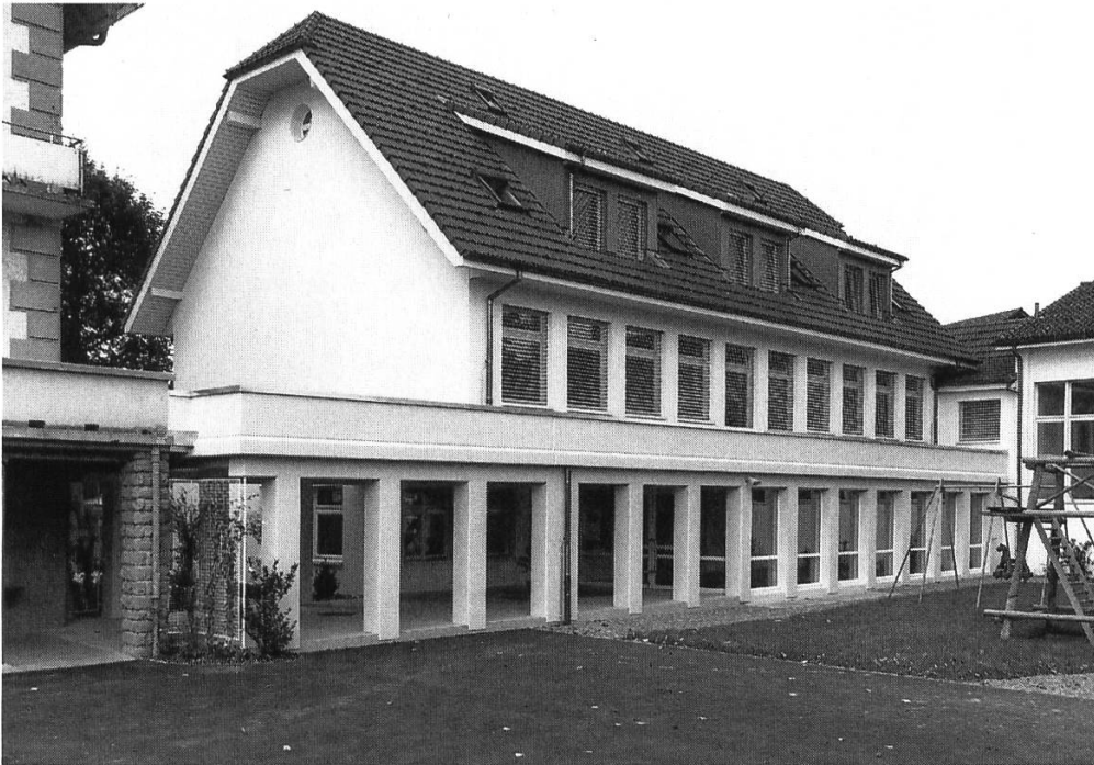
Erweiterungsbau von 1993/94 mit Schulzimmern und Bibliothek. Aufnahme 1994.
