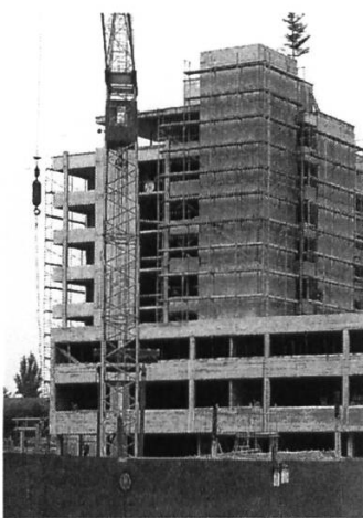
Erneuerung und Ergänzung des kantonalen Spitals 1990.
