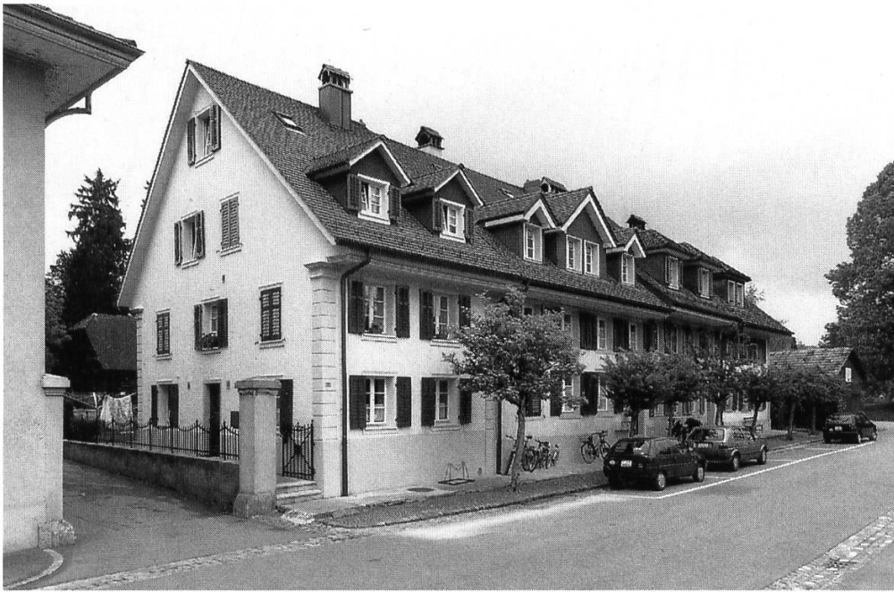
Die seinerzeit vom Abbruch bedrohten Häuser an der Beckenhofstrasse erstrahlen in neuem Glanz. Aufnahme 1997.
