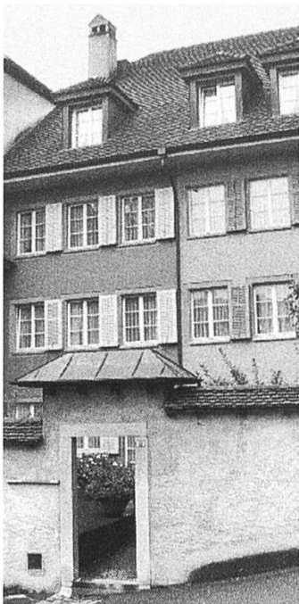
Wo früher zwei Pfrundhäuser von Geistlichen standen, befindet sich heute das Sozialzentrum am Herrenrain 12.
