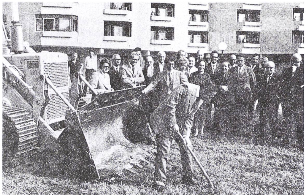
Bürgerpräsident Werner Portmann beim ersten Spatenstich im September 1972 zum Bau der neuen Alterswohnungen in Sursee.
