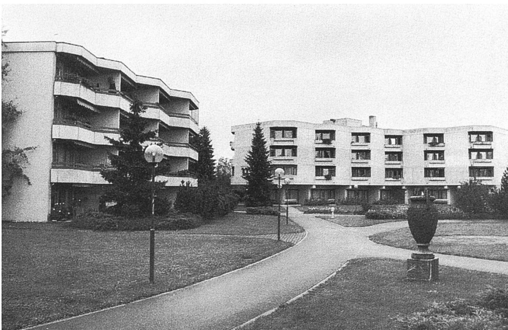
Die Alterssiedlung St. Martin mit dem Alters- und Pflegeheim von 1968/69 und den Alterswohnungen von 1972/73.
