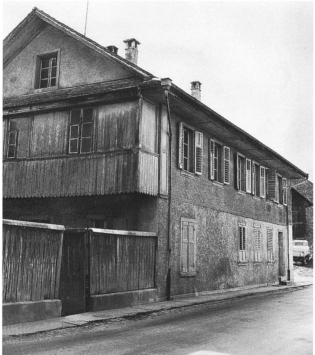
1883 wurde an Stelle des alten Wasch- und Holzhauses ein Anbau errichtet, welcher anfänglich die Schweineställe im Erdgeschoss, die Irren- und Krankenzellen im Obergeschoss barg. Aufnahme um 1970.
