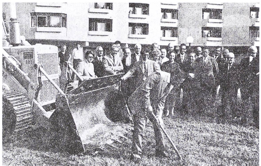
Bürgerpräsident Werner Portmann beim ersten Spatenstich im September 1972 zum Bau der neuen Alterswohnungen in Sursee.
