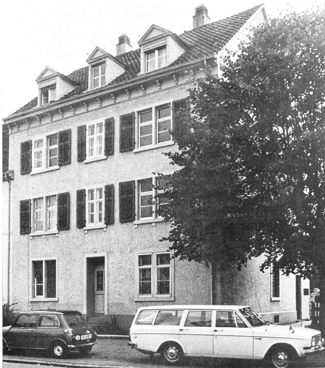
Vom Drop-in gemietet: Haus Hard- strasse 20 in Birsfel- den. Photo: Kurt Baumli
