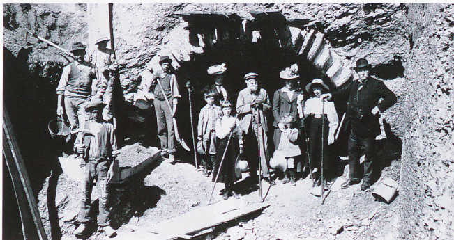
Adolf Guyer-Zeller et sa famille en visite sur le chantier en 1897
