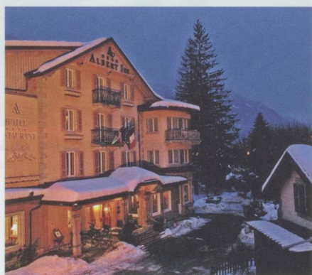
La façade de l'Albert I er
