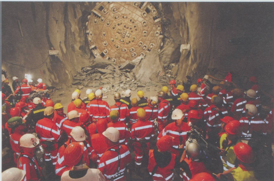
Le 15 octobre 2010, le percement du tunnel ferroviaire du Gothard est achevé
