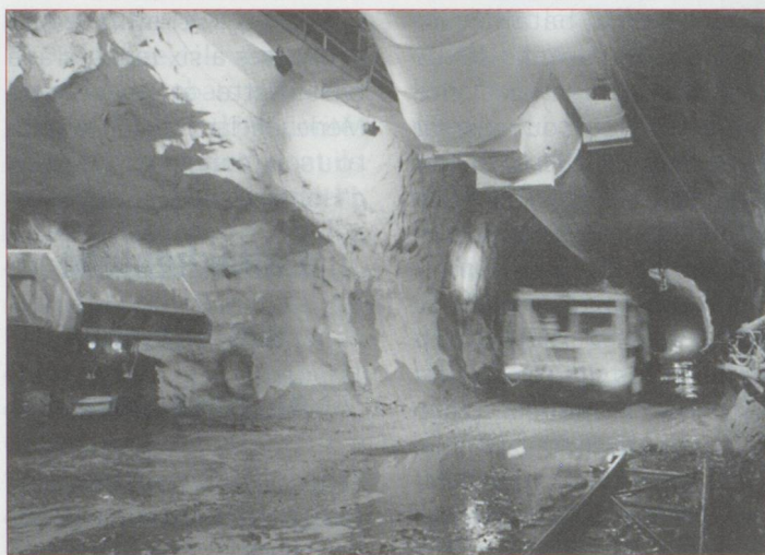
Marinage des déblais.
