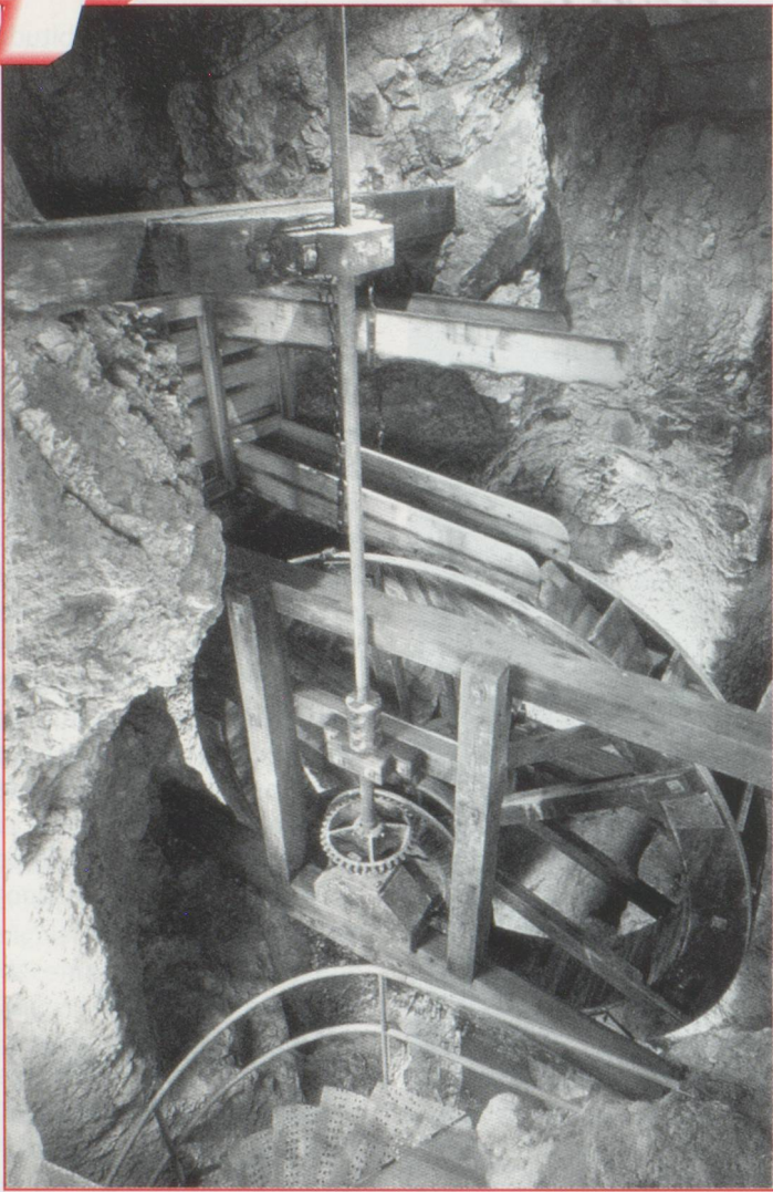
Roue hydraulique du puits 2.
