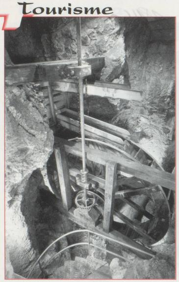
Roue hydraulique du puits 2.
