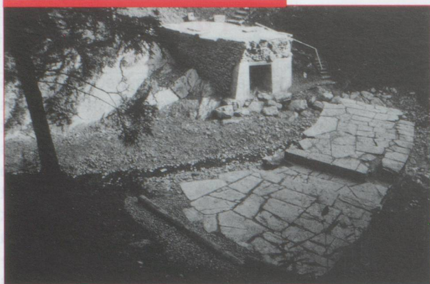
Restauration terminée, vue sur la culée droite, le béton soutient la partie subsistante en porte-à-faux (photo D. Ruchet). Beendigte Restaurierung mit Ansicht auf das rechte Widerlager, der Beton stützt den noch erhaltenen, auskragenden Teil (photo : D. Ruchet).
