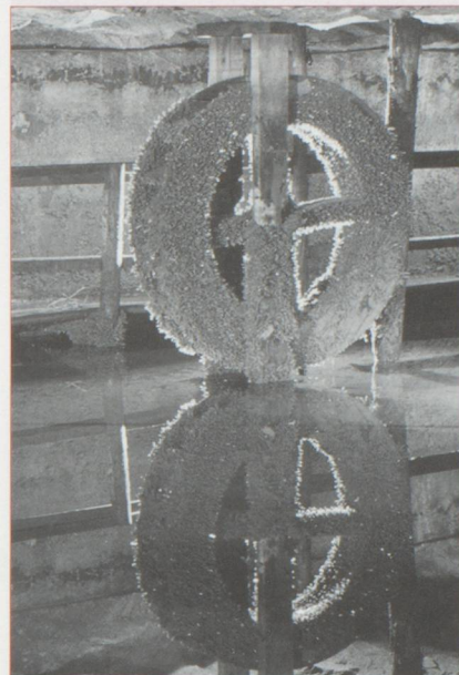
Roue volumétrique pour décompter la saumure extraite
