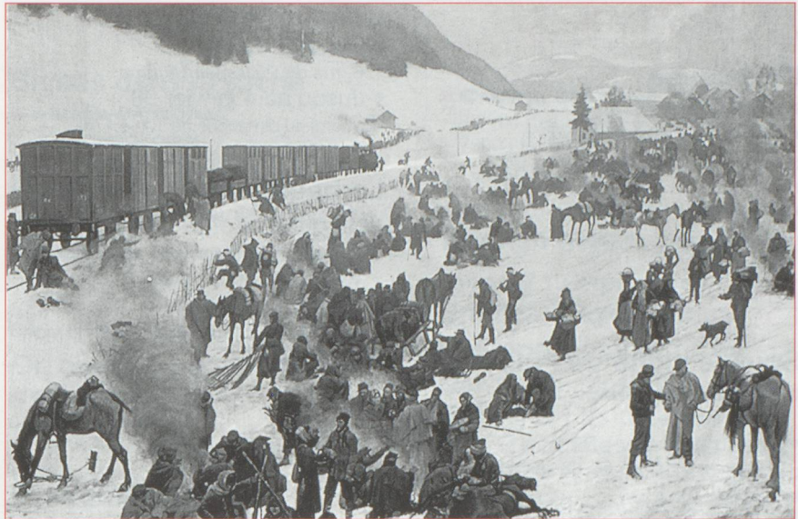
Les travaux de restauration du Panorama Bourbaki ont débuté à Lucerne.
