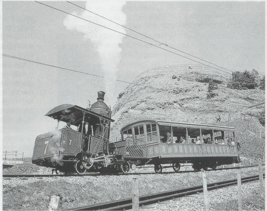
La locomotive à chaudière verticale n°7, restaurée, en tête du wagon « nostalgie » datant de 1871, circule sur le trajet Rigi-Staffel - Rigi Kulm jusqu'au 20 octobre.
