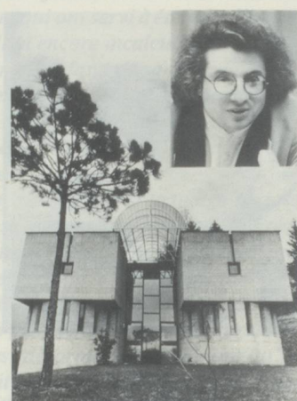
Le célèbre architecte tessinois Mario Botta a reçu le fameux «Chicago Architecture Award» pour 1986. (Photo: L'une de ses réalisations, une maison familiale)
