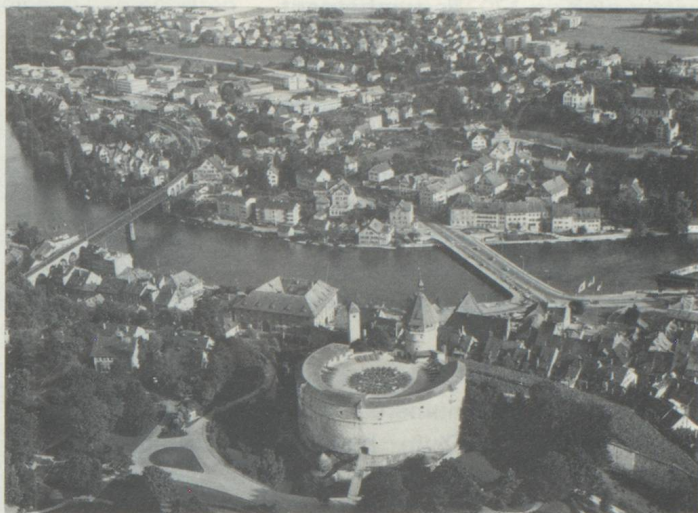
Schaffhouse au coude du Rhin/Suisse orientale. Vue aérienne sur la forteresse circulaire du Munot, la vieille ville de Schaffhouse et Feuerthalen de l'autre côté du Rhin.
