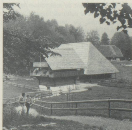
Grange à trois étages de Kiesen (Berne), édiflée avec des demi-poutres. On voit en second plan la maison de Madiswil (plateau du Mittelland bernois) de 1710 : sous le même toit, logements jumelés avec cuisine commune.
