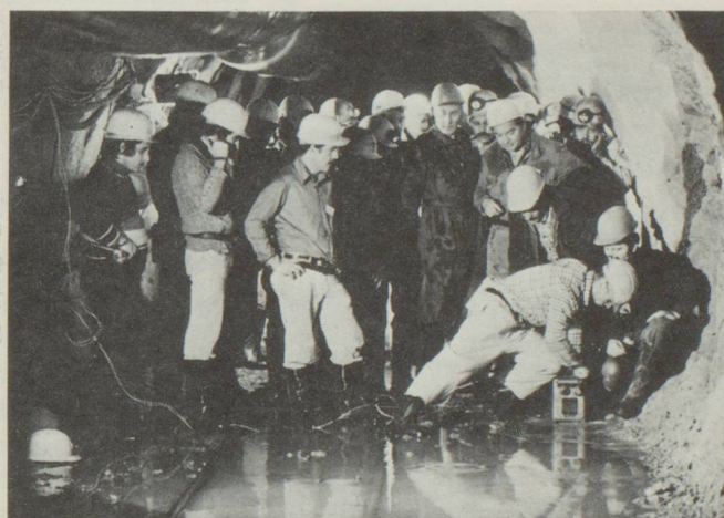
Le tunnel routier du Gothard prend forme; ici le dernier coup de mine.
