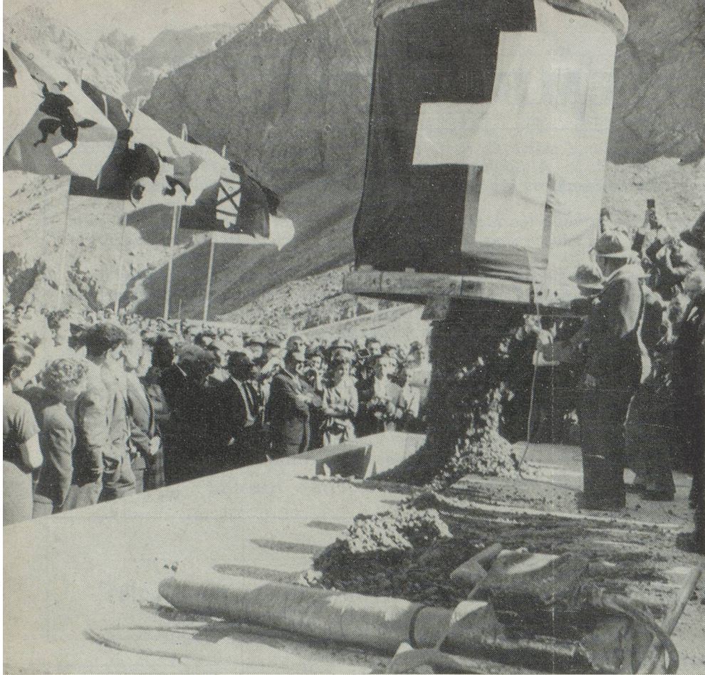
Le plus haut barrage du monde, — il atteint, avec 284 mètres, presque la hauteur de la Tour Eiffel —, est désormais achevé : le 22 septembre, en présence de près de 3.000 ouvriers et invités, la millionième benne de béton a été coulée dans l'emplacement réservé.
