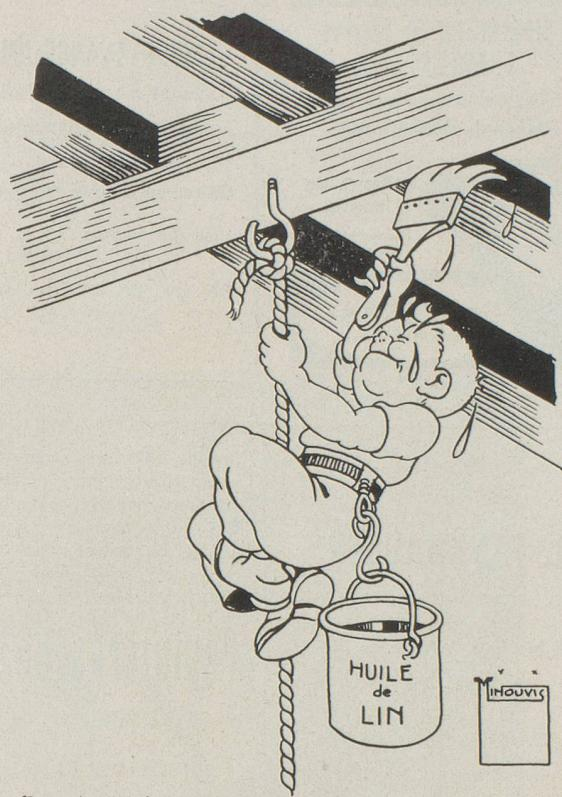
On préserve les poutres apparentes des maisons de campagne, contre l'humidité en les enduisant d'huile de lin. Mais en la faisant chauffer, jusqu'à ce qu'une légère fumée se dégage; l'huile de lin pénètre ainsi plus profondément dans le bois. Utilisez un pinceau dit « queue de morue. »
