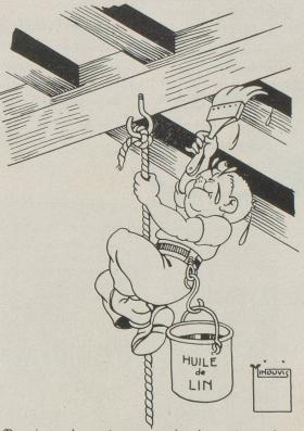
On présezve les poutres apparentes des maîsons de campagne, contre l'humidité en les enduisant d'huile de lin. Mais en la faisant che , lez jusqu'à ce qu' une légère fumée se dégage; l'huile de lin pénètreza ainsi plus protondement dans le bois. Utilisez un pinceau dit « queve de mozue. »
