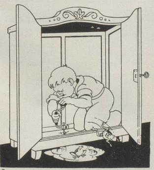
Pouz évitez l'humidite des azmoizes ou placazds dans les maisons de campagne Pratiquez des ouvertures dans le haut et le bas du placazd, les recouvriz d'une toile métallique fine afin d'empéchez le passage des insectes. L'aiz cizculant ainsi de bas en haut il n'y auza plus de traces
