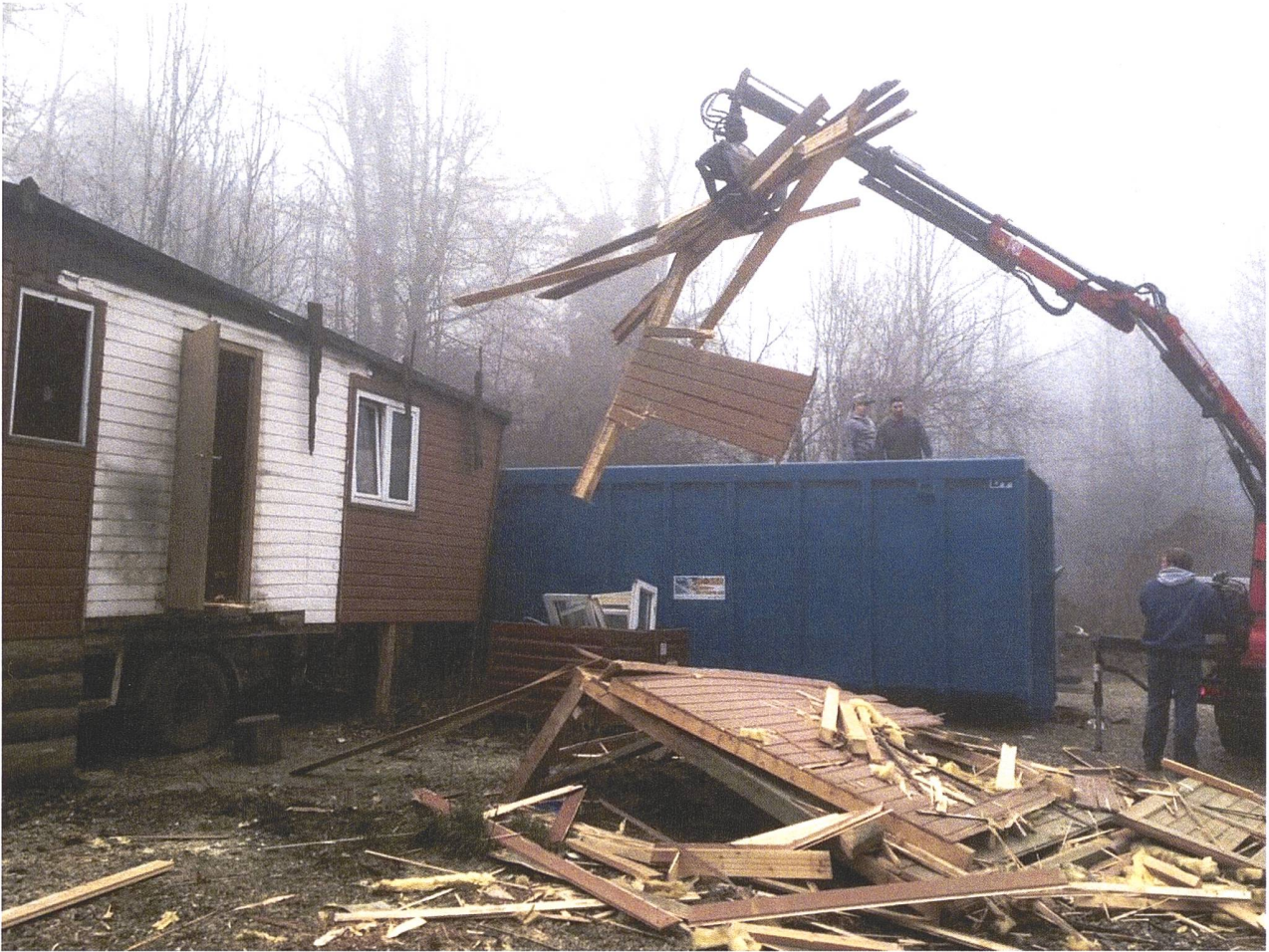
Oben: Der Abriss (Januar 2016). Unten: So war es vorher, ein Idyll.
