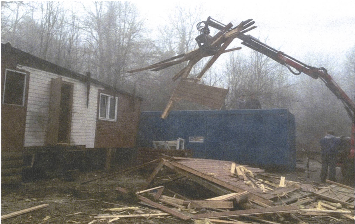
Rüttenen SO, Beginn des Abbruchs (Foto Charles Huber)
