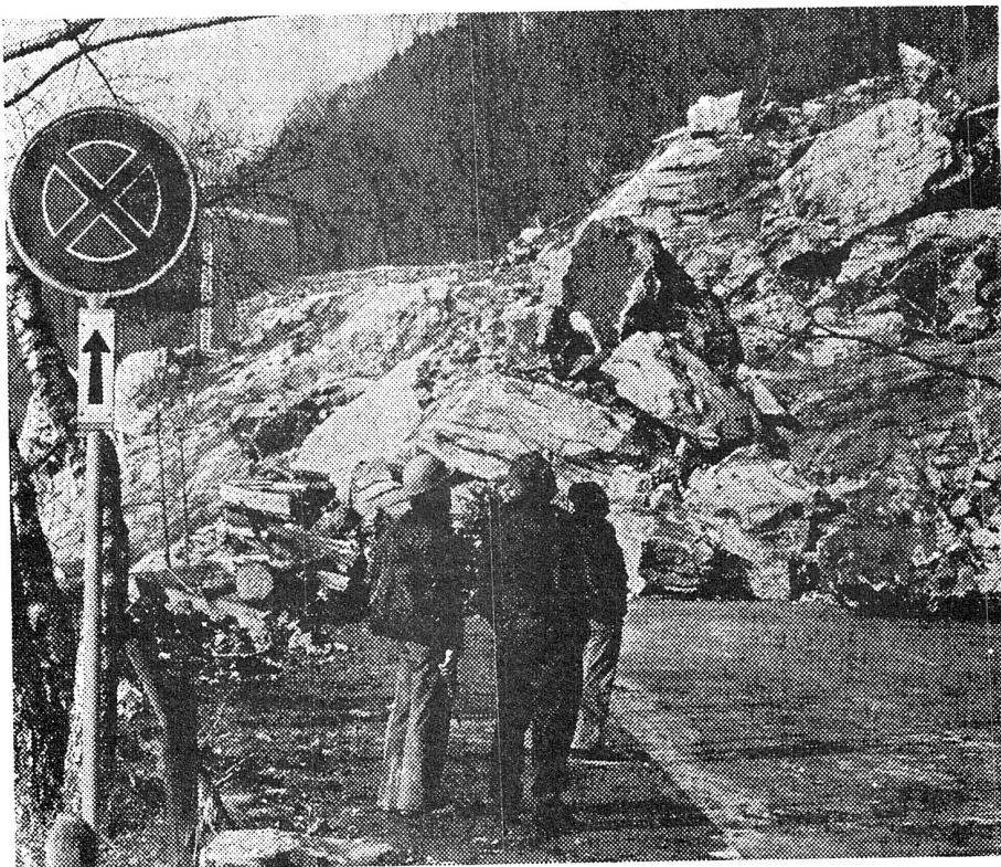
Die Situation nach dem Felssturz, der die Kantonsstrasse in der Nähe von Gersau verschüttete. Photo Widler
