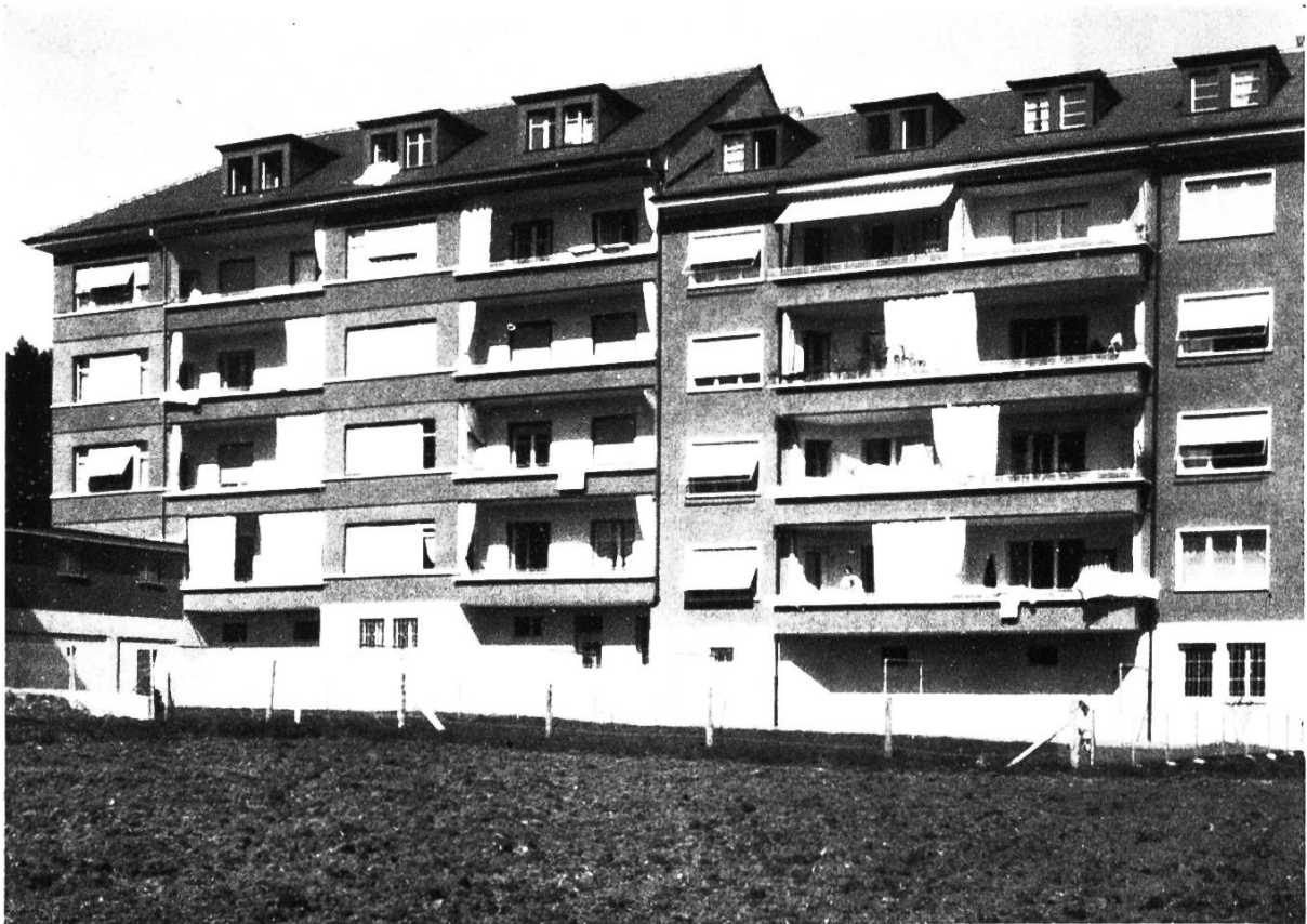
Oben: Neufeldstrasse (Länggasse) Unten: Südbahnhofstrasse (Weissenbühl)
