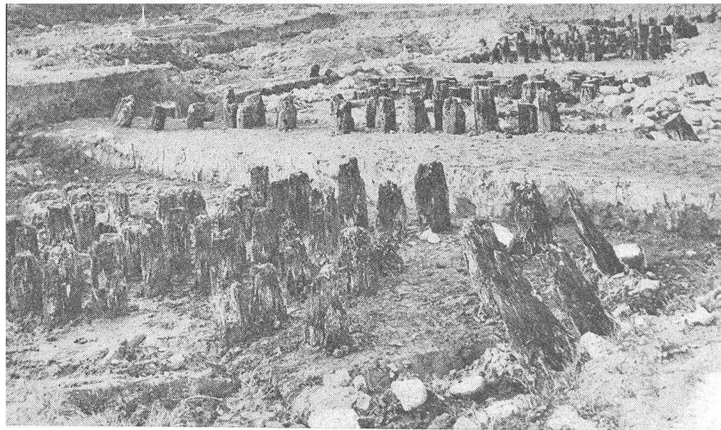
Pfähle der römischen Militärbrücke von «Le Rondet» an der Broye
