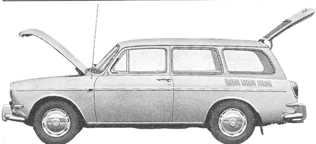
Doch. Im Heck wie sein Bruder, der VW 1200, der damit Weltberühmtheit erlangt hat. Der Motor des VW 1500 Variant ist nur 43 cm hoch und deshalb unsichtbar unter der hintern Ladefläche angebracht. Der Laderaum faßt 1,2 Kubikmeter. Wenn er gefüllt ist, hat's unter der vordern Haube noch einmal einen Gepäckraum.
