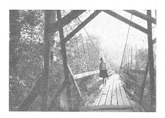
Das Hängebrücklein, das seit 1885 flußabwärts von Freiburg bei Bad Bonn über die Saane führte, stürzte wegen Überbelastung ein! Allerdings hätte dieser Steg in den nächsten Monaten ohnehin abgebrochen werden müssen, weil das Tal dem Stausee des Kraftwerkes Schiffenen geopfert werden mußte.
