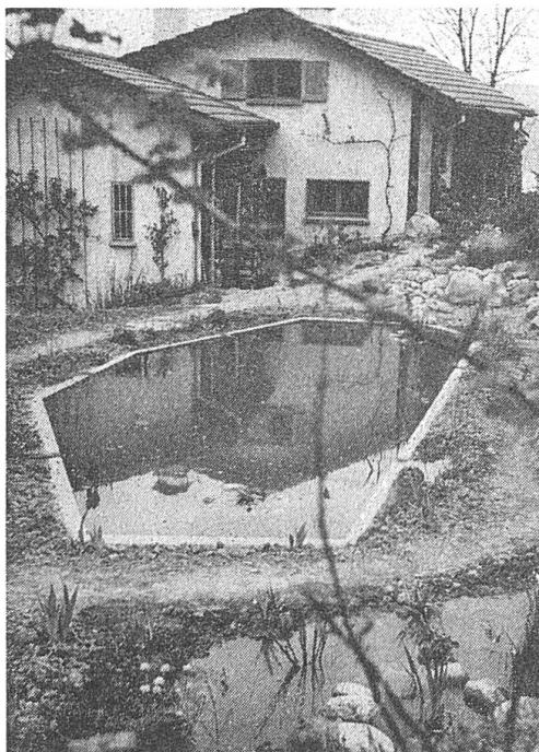
So sehen Sumpf (Vordergrund) und Weiher etwa zwei Wochen nach dem Auffüllen mit Wasser aus. Im Betonrand sind deutlich die Überläufe in den Sickergraben sichtbar.
