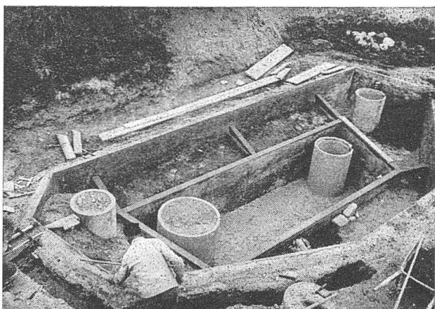
Das ist der fertig betonierte Weiher mit seinen Kammern. Im Hintergrund rechts ist der schon wieder aufgefüllte zukünftige Sumpf sichtbar. Kammern und Röhren sind teilweise gefüllt, und um den Weiherrand ist ein Teil des Sickergrabens ausgehoben.
