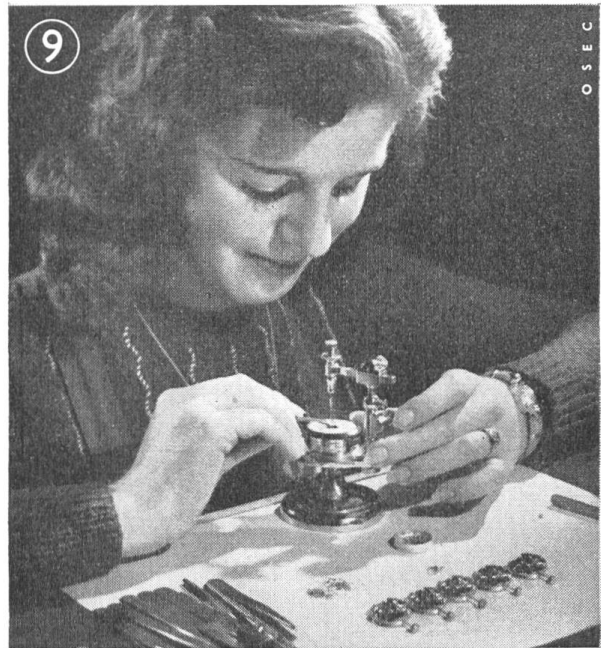
Das Ausregulieren der haarfeinen Spiralfedern.
