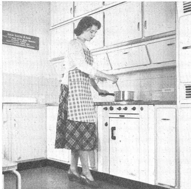
Moderner Einbaugasherd mit Schwingtüre und Temperaturregler. Der Temperaturregler garantiert automatisch die richtige Temperatur im Backofen, so daß das Gebäck auch ohne ständige Überwachung gelingt. Die modernen Gasherde sind hell feuерemailliert. Neuartig ist die gute Ausnützung der Wandfläche mit den unten abgeschrägten Kästchen.
