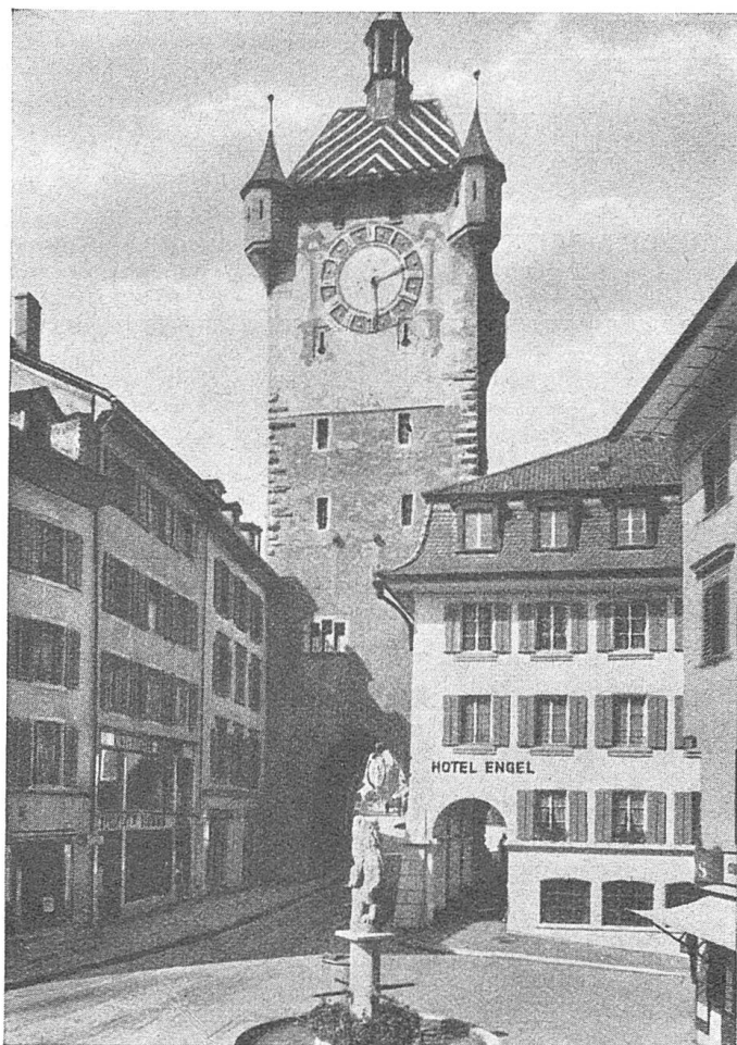
Schonende Verkehrsverbesserung: die neu angelegte Laube im Erdgeschoß des Hauses rechts schafft einen sicheren Fußgängerdurchgang, ohne das Stadtbild zu stören. (Baden, Stadtturm)
