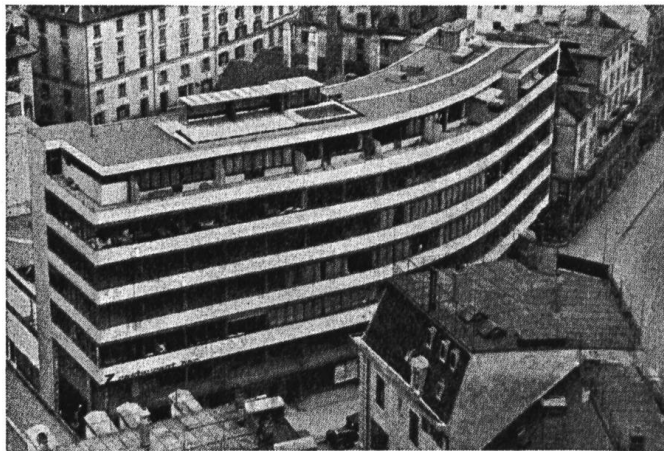
Technischer Stil Geschäftshaus mit den technischen und formalen Mitteln des Fabrikbaus. « Z-Haus » Zürich, 1930—1932.
