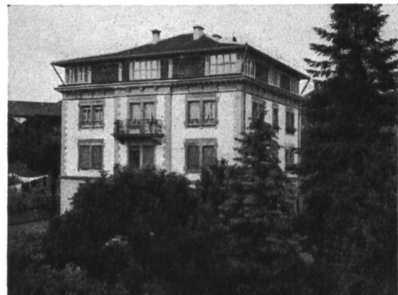
Nach dem Umbau
