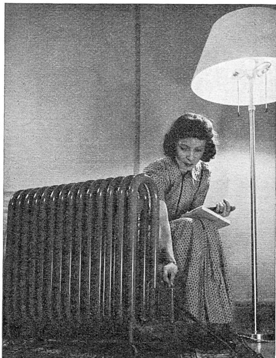
Die sauberste und bequemste Heizung der Wohnräume erzielt man mit **Forster Elektro-Radiator**. Dank seiner Oelfüllung erzeugt er eine absolut gleichmässige Wärme. Er ist in jeder gewünschten Spannung und Farbe lieferbar, passt sich also jedem Raum an. Eine eingebaute Wasserschale sorgt für die nötige Verdunstung.
