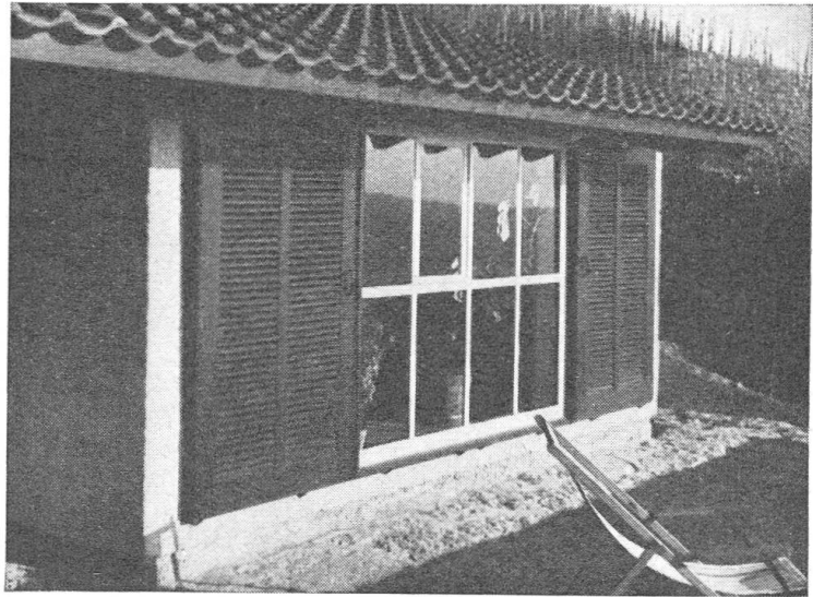
Das Aussichtsfenster des Hauptraumes von aussen, verschliessbar mit hölzernen Schiebläden.
