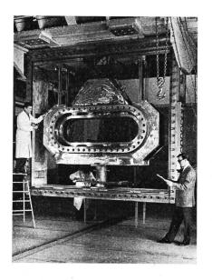
Abbildung 17 Kammerkörper (rostfreier Stahl) der CERN Wasserstoffkammer beim Einbau in den Väkuumtank
