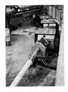
Abbildung 24 Strahlführung eines herausgelenkten Teilchenstrahls vom CERN-PS.
