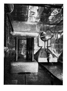
Abbildung 6 Cockroft-Walton Beschleunigungsstufe des CERN-PS
