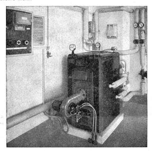
OERTLI-Kleinautomat-Oelfeuerung für kleinere Zentralheizungen
