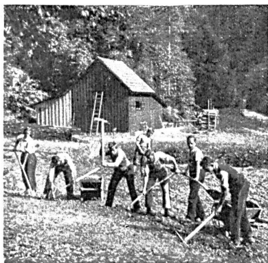
Ausbesserung eines Erdschlupfes bei Einsiedeln
