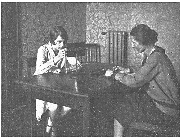
Bild 2: Prüfung des Augenmasses durch das Platyskop.
